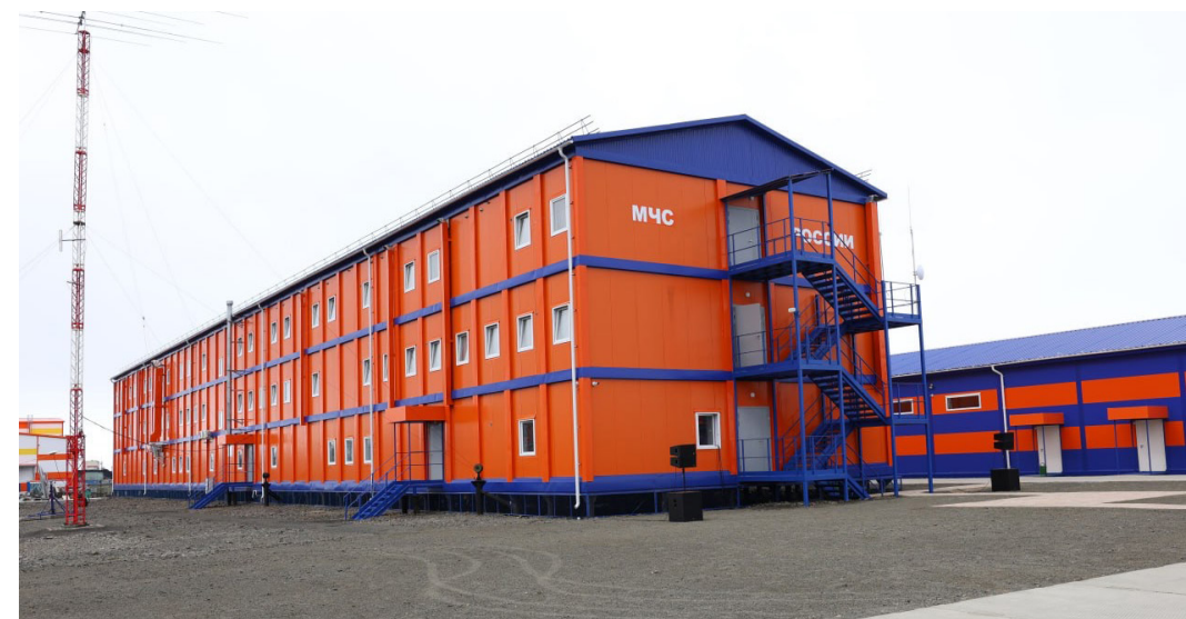
Арктический комплексный аварийно-спасательный центр главного управления МЧС России по Чукотскому автономному округу (г. Певек)
