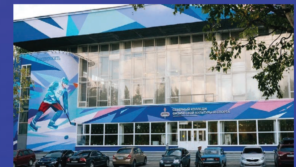
Капитально отремонтировали фасад колледжа физической культуры
