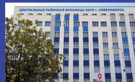
Капремонт ЦРБ, Североморск
