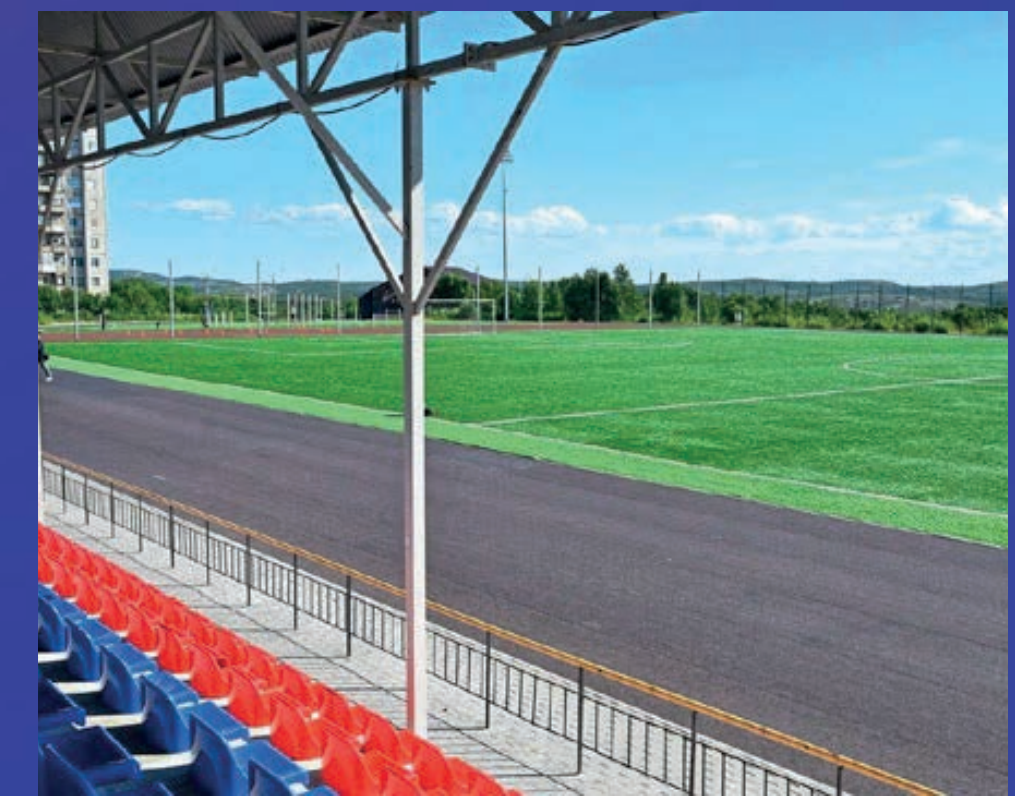
Отремонтировали стадион в Снежногорске
