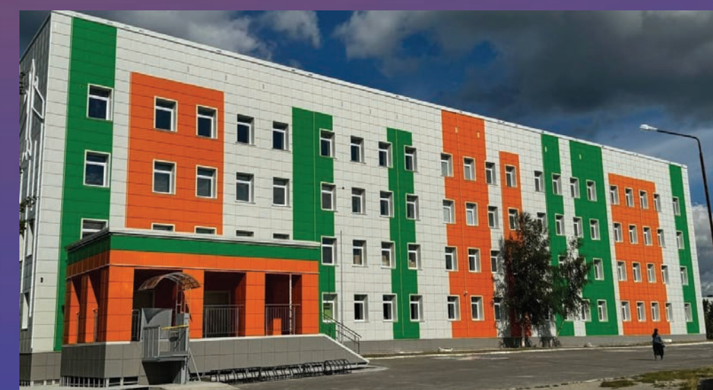
Капитально отремонтировали школу в Высоком
