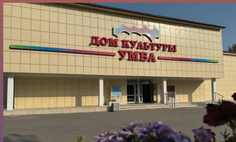
Отремонтировали Дом культуры «Умба»
