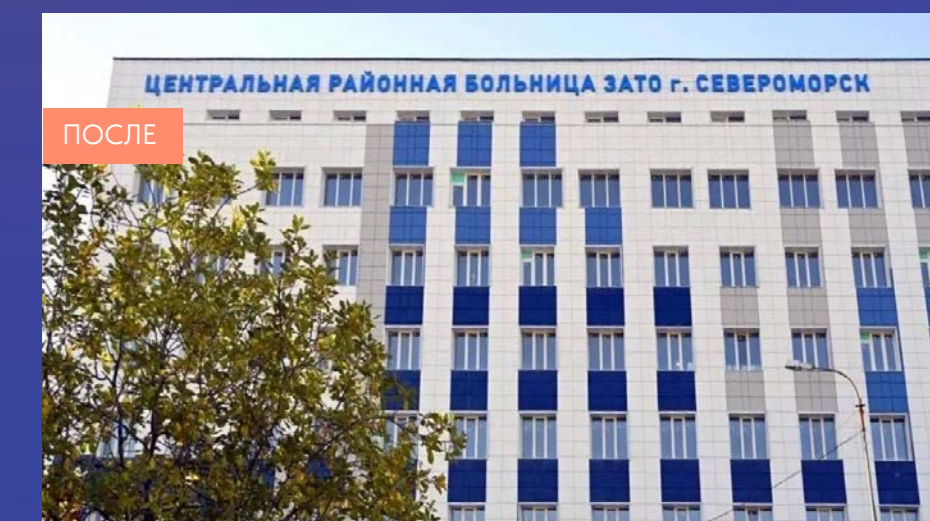
Капитальный ремонт Североморской ЦРБ
