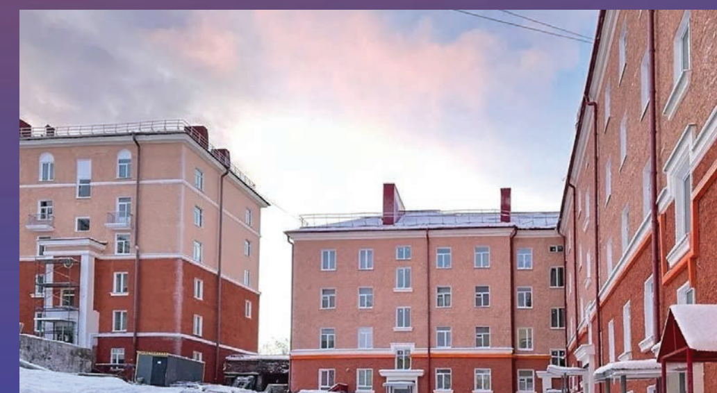
Провели работы по капитальному ремонту домов
