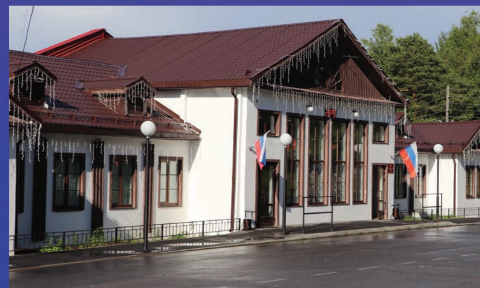
Капитально отремонтировали культурно-досуговый центр в Зареченске
