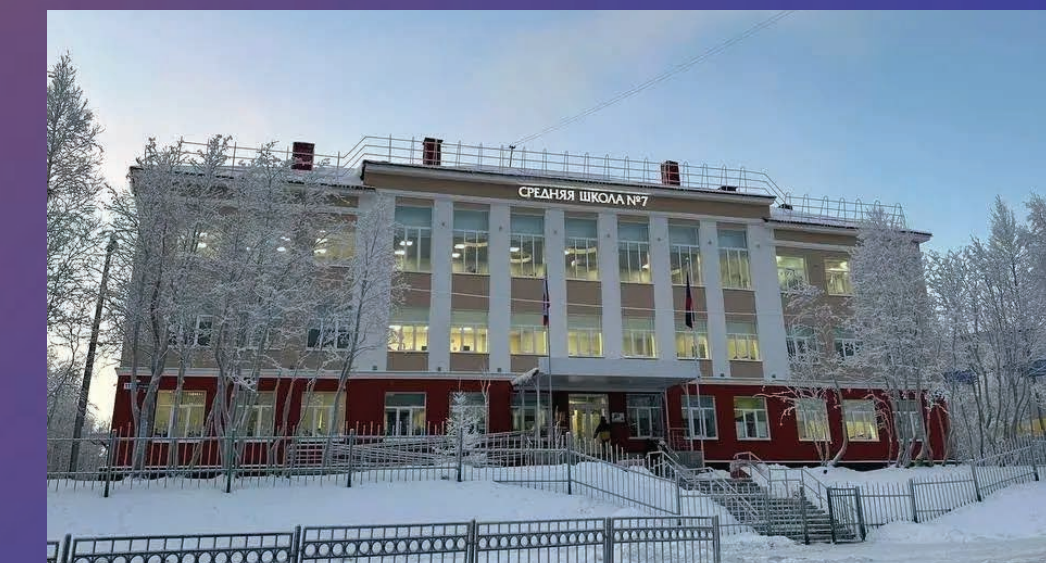
Капитально отремонтировали школу №7
