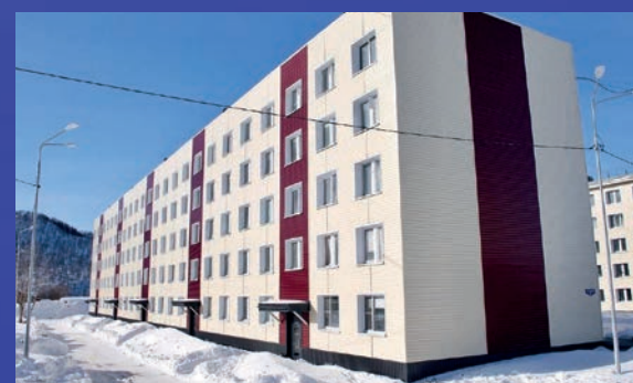
Капремонт домов, Спутник
