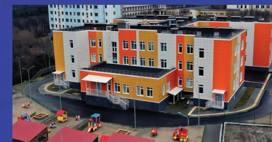
Построили детский сад на 220 мест в Североморске
