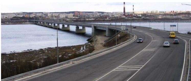
Мост через Кольский залив
