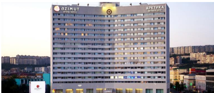
Реконструкция гостиницы «Арктика»
